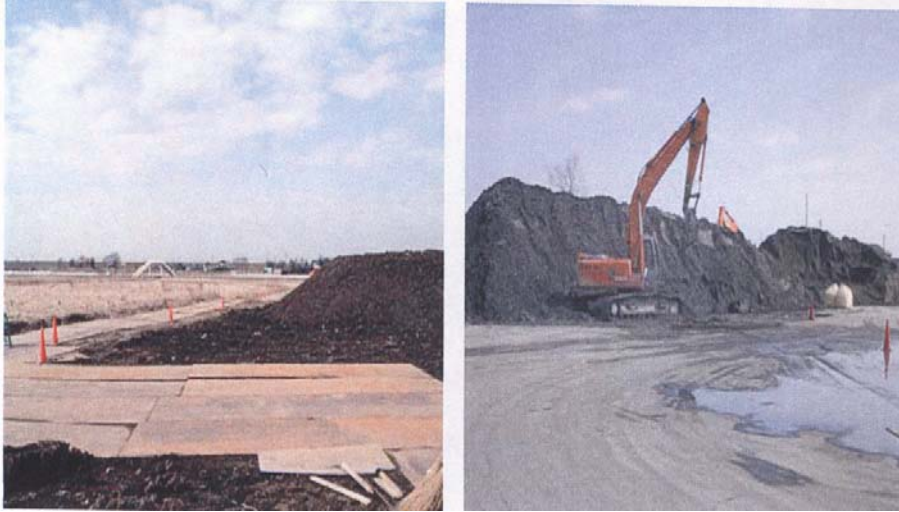
تصویر ۶: خاکبرداری از مکان‌های ساخت و ساز زیرزمینی برای نواحی پست مادرشهر توکیو
