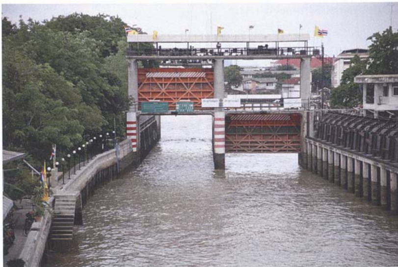
تصویر ۷: دروازه‌های آبی به مثابه سازه‌های اساسی در کنترل سیل در بانکوک
