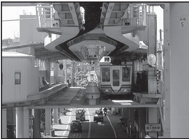
شکل شماره ۳-۹: مسیر رفت و برگشتی در یک خط و عبور قطارها از کنار هم در ایستگاه‌ها، مونوریل شونان ژاپن [۹]
