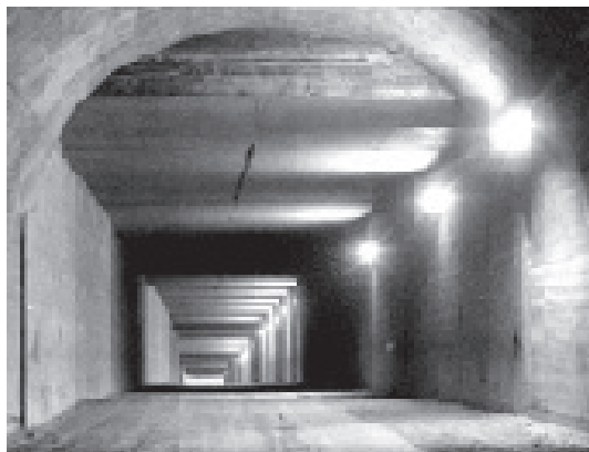
شکل شماره ۵-۵: تونل حفر شده با روش ترانشه باز
