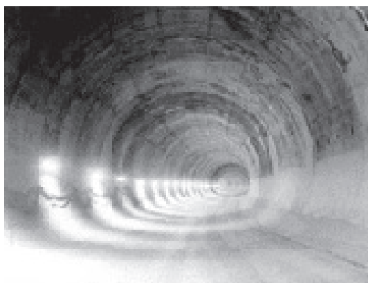
شکل شماره ۵-۶: تونل حفر شده با روش اتریشی
