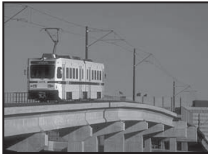
شکل شماره ۲-۱: مسیر غیر هم‌سطح قطار سبک شهری، سن خوزه، آمریکا. به شیب تند پل در سمت راست توجه کنید
