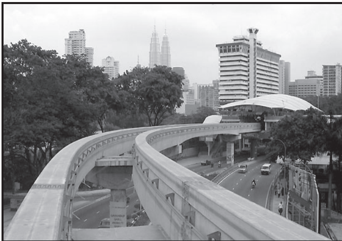
شکل شماره ۳-۱۸: مسیری با تیر قوسی بتنی [۹]
