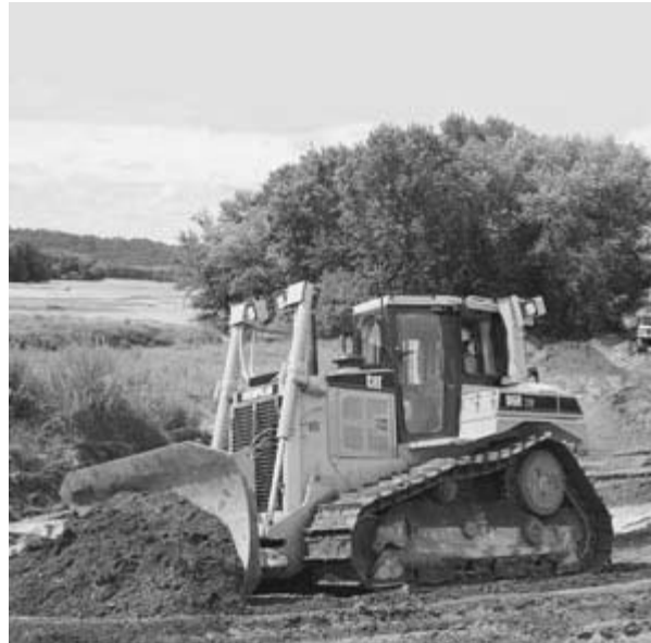
شکل ۵-۵: بولدوزر در حین عملیات خاکی
