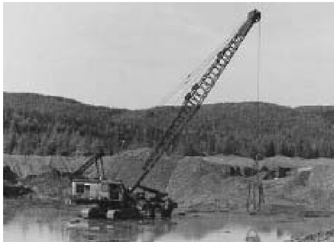
شکل ۵-۳۴: یک دراگلاین در حال عملیات خاک برداری
