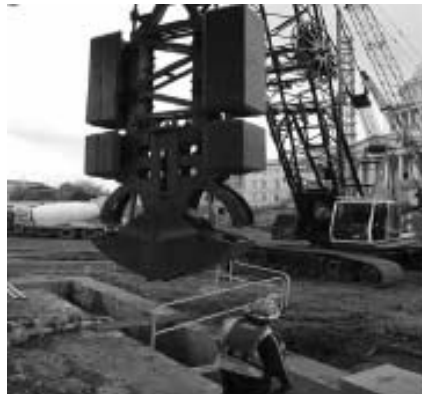
شکل ۲۶-۵: کلامشل در حال عملیات در خاک
