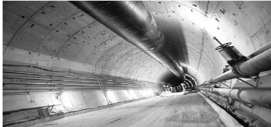
شکل ۵-۴۳: تونل حفاری شده به روش مکانیزه بعد از نصب سگمنت های بتنی
