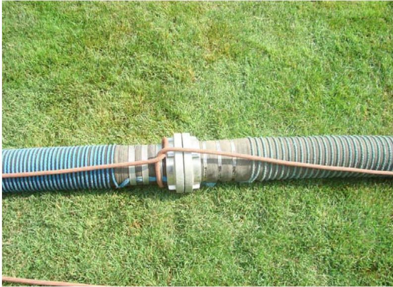
شکل شماره ۳-۱۰. گره نیم خفت بر روی لوله‌های خرطومی را به منظور جدا نشدن لوله‌های خرطومی از یکدیگر زده می‌شود.
