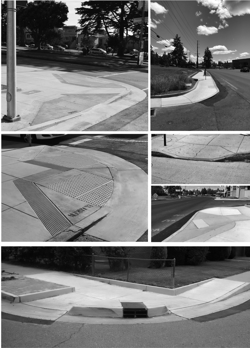
انواع جداول در محل اتصال پیاده‌رو به سواره‌رو برای عبور دوچرخه و ویلچر
