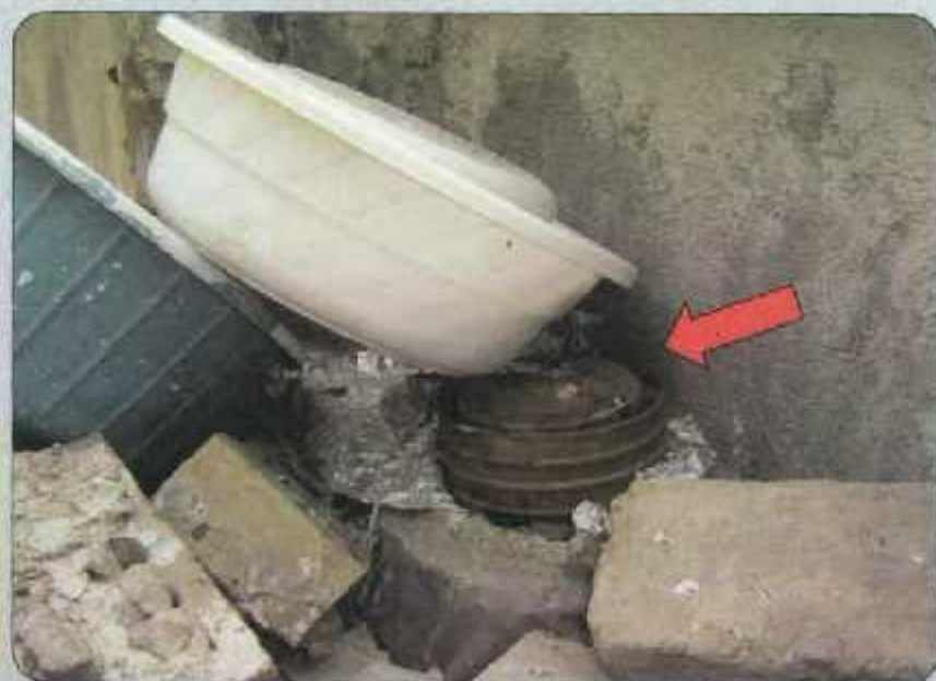
کلاهک و بخش عمودی غیر استاندارد و قرار دادن اثاثیه بر روی کلاهک در پشت بام
