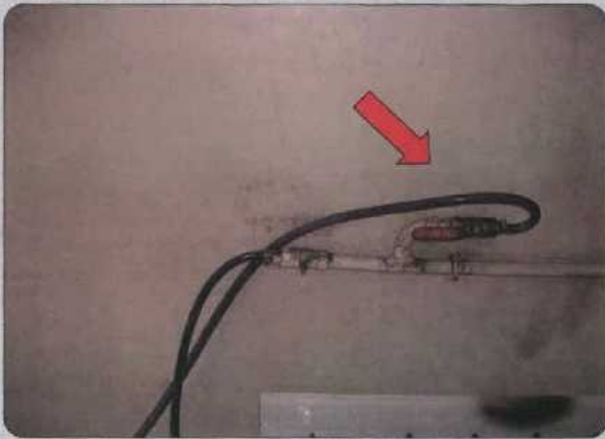
استفاده غلط از شیرنگ گاز
