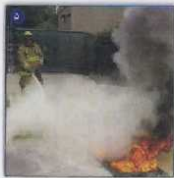
5- توان خروجی را به سمت پایه شعله بفرستید، از نزدیک به آتش شروع کرده و به سمت عقب ادامه دهید.
