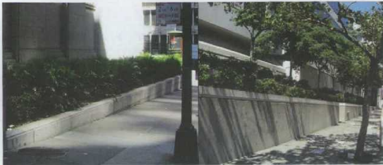
تصویر ۱۲- یک مانع نسبتاً کوتاه که سد قابل توجهی در برابر اتومبیل ها است. در سمت راست مانع بلندتری در اطراف ساختمان وجود دارد
