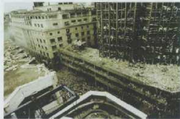
تصویر ۶- خسارت به ساختمان های اطراف محل انفجار
