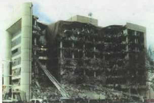
تصویر ۷- ساختمان مرکز موراه، شهر اوکلاهما، ۱۹۹۵
