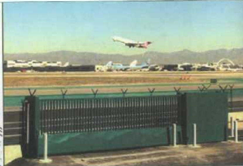
تصویر ۱۸- نصب درز معمولی در سمت چپ و درز متحرک در سمت راست
