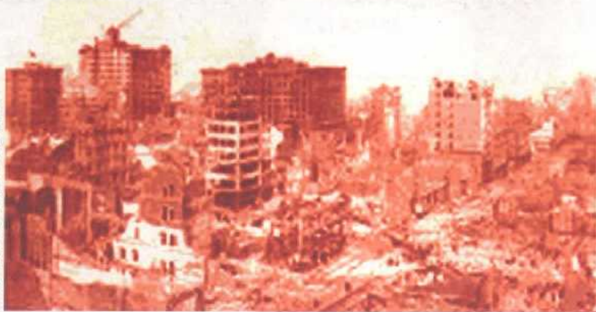
مختاری از شهر ساغریس پس از حوادث حریق در زمین لرزه ۱۹۸۴
