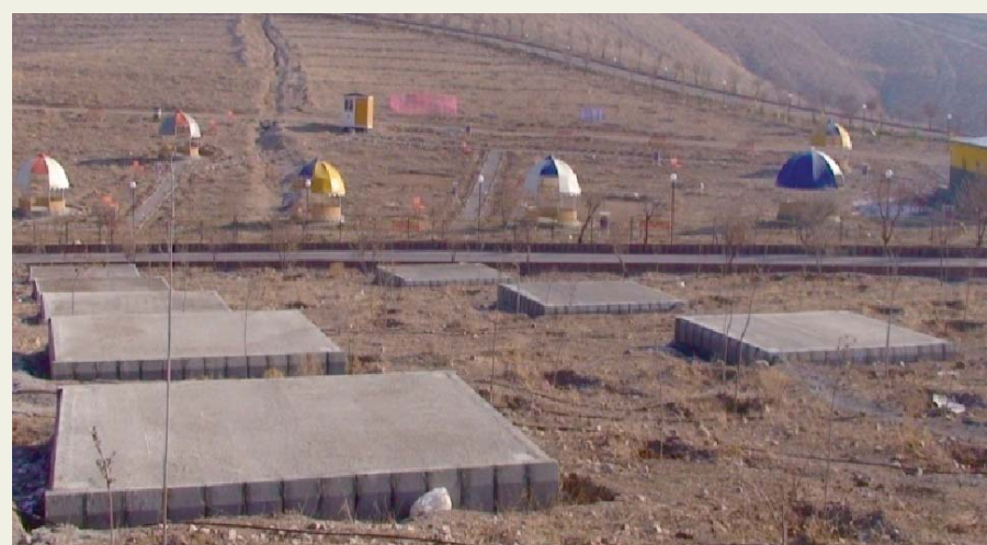
تصویری از سکویهای احداث شده در فاز ۲ پارک عباس میرزا
