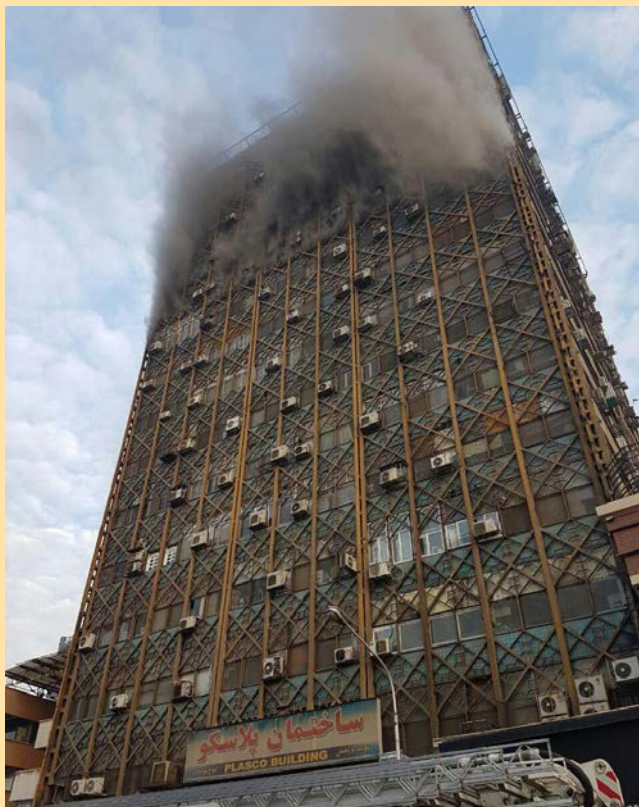
ساختمان پلاسکو پس از آتش سوزی
