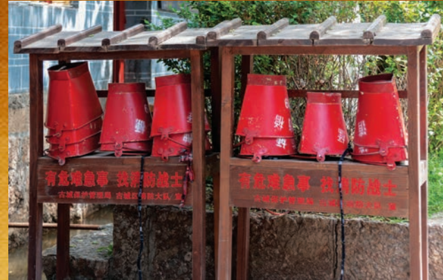
سطل آب آتش‌نشانی
