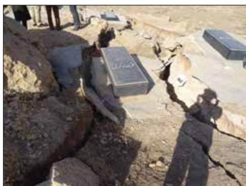
شکل ۱۰. نمایی از تخریب‌های حاصل از زمین لغزش مله کبود (IIEES)
