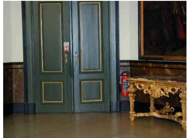
نصب هوشمندانه خاموش کننده دستی بدون لطمه به چیدمان قدیمی تالار
