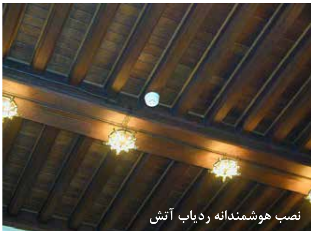
نصب هوشمندانه ردیاب آتش
