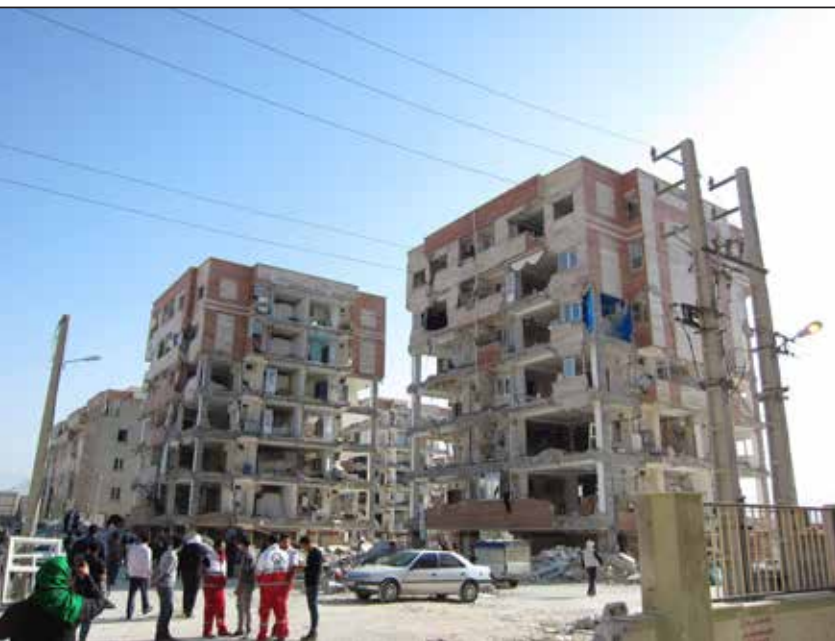
شکل ۱. خرابی های شدید در ساختمان های نوساز مسکن مهر سرپل ذهاب
