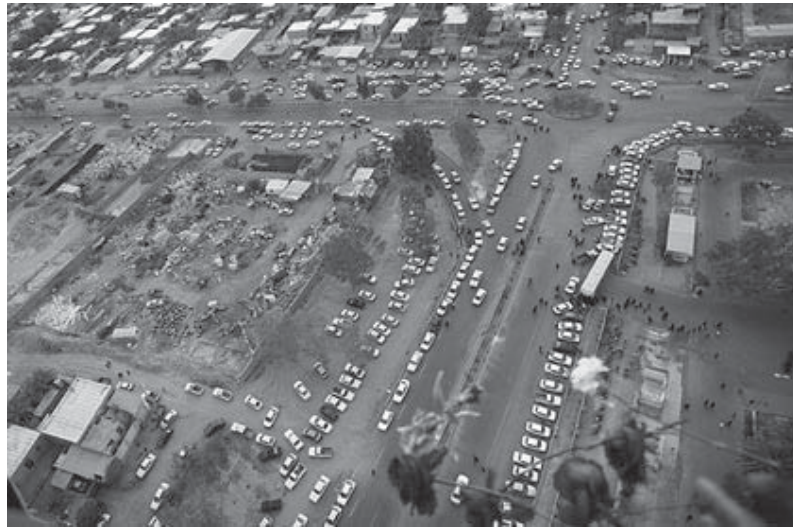
تصویر ۴. تصویر از معابر شهر بم در فرآیند بازسازی؛ چنانچه مشهود است هیچ گونه استراتژی خاصی در فرآیند طراحی شهر در راستای کاهش میزان جرم خیزی دیده نمی‌شود؛ ماخذ: نگارنده، برداشت میدانی.
