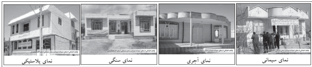
تصویر ۳. نمونه هایی از واحدهای مسکن روستایی از محل تسهیلات طرح ویژه با مصالح متنوع به ترتیب: سیمانی، آجری، سنگی و حتی پلاستیکی؛ مأخذ: آرشیو بنیاد مسکن
