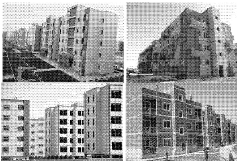
شکل ۴. نمود طراحی نما در پروژه مسکن مهر شهر جدید پردیس
