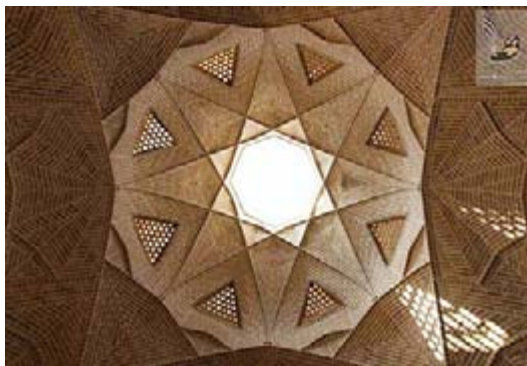
تصویر ۵. نقش هشتی؛ مأخذ: نگارندگان. هشتی، پس از درگاه خانه بوده در حکم نوعی حیاطچه بیرونی برای خانه عمل می کرد. به شکل های مختلفی مانند چهارضلعی مربع یا مستطیل، هشت ضلعی و غیره ساخته می شد.
