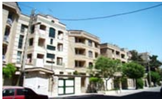
تصویر ۴. بالکن‌های اجرا شده در پخ ۴۵ درجه
