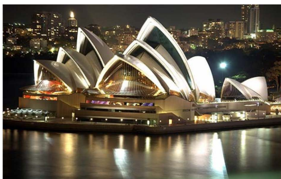
تصویر ۲۳. معماری سقف اپرای سیدنی و بکارگیری از سازه پوسته‌ای در آن؛ ماخذ: اینترنت
