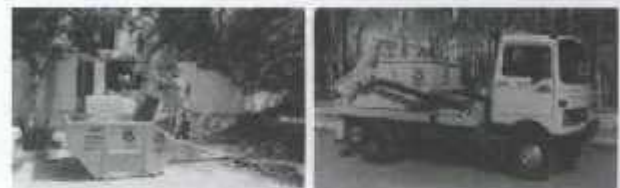
تصویر ۱- مخازن اسکپ جهت ذخیره سازی
