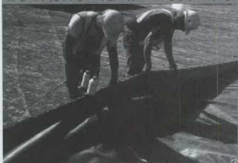
شکل شماره ۴: نحوه پوشش لایه چنانگنده ژئوتکستایل در حد حاصل لایه رس و لایه زهکش شیرابه
