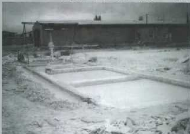
تصویر ۲- حوضچه های رسوبگیری در یک کارخانه با نگهداری ضعیف؛ پس از تخریب و خشک شدن گنجا تخلیه و به محل دفع منتقل می شود
