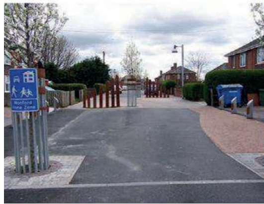
نصب موانع برای کاهش سرعت وسایل نقلیه
