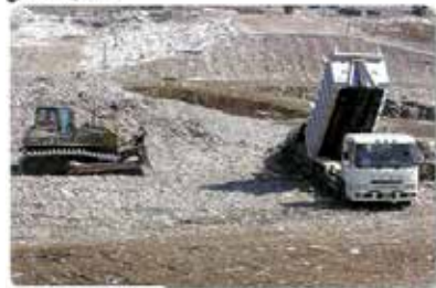
روشنی سبک تدوین بعد از پوشش خاک مناسب روی پسماند دفن شده مجدداً پسماند ریخته و عملیات دفن به پیش می رود.
