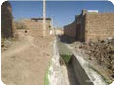
احداث کانال سرپوشیده
