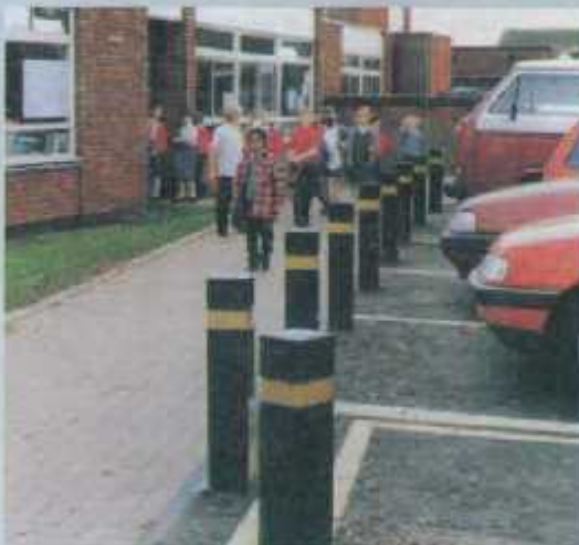
تصویر شماره ۹- نصب تیرک در فرودگاههای تیرک بدون عرشه
