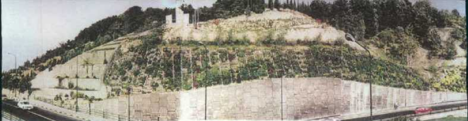
کشت گیاه در بالای دیواره عمودی بتنی، بزرگراه مدرس تقاطع غیرمسطح با شیب صفت
