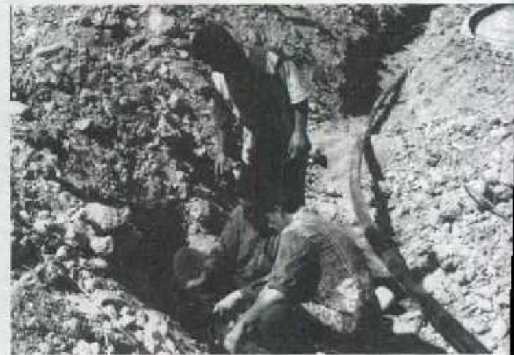
کرج - عملیات لوله گذاری انتقال آب خام
