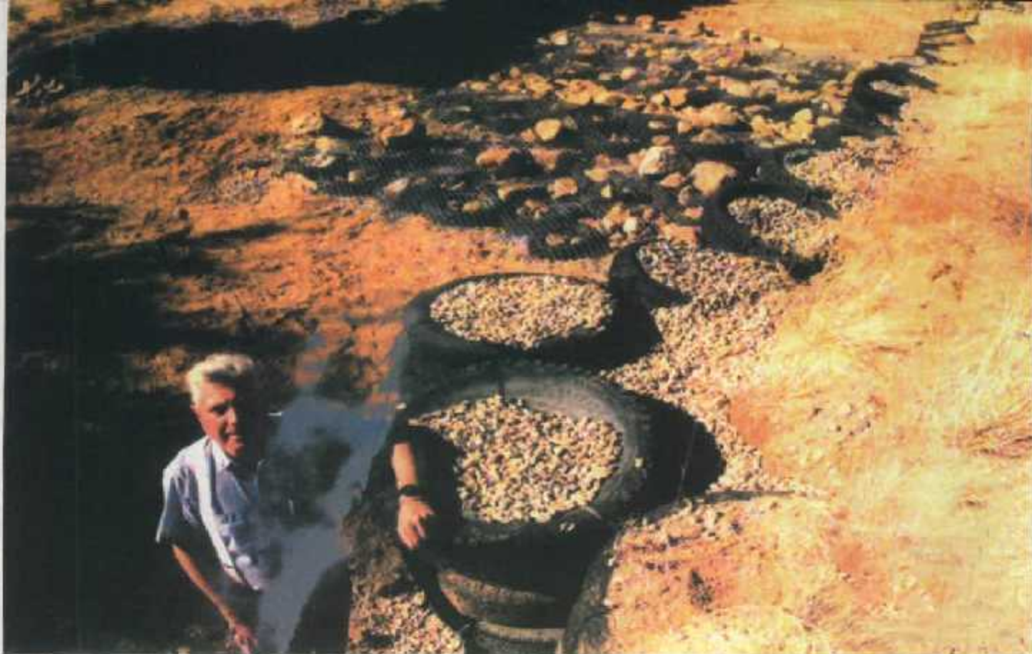
پروفسور بازنشسته استوارت هونیک، یک منبع استفاده از لاستیک های فرسوده برای کنترل فرسایش و کاربرد های دیگر، او در کنار سد و که زیر نظر شهرداری پدیده از لاستیک ساخته شده است رود می باشد. خوردن این سد و اطراف آن گرده است در این تصویر، و بدون فرسودگی برای ساختن فراس باغ، مورد استفاده قرار گرفته است. آنچه در تصویر دیده می شود، مراحل کار، بلافاصله پس از آماده سازی، در مرکز مطالعات احیا - کالیفرنیا است.
