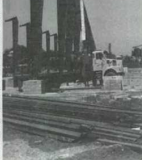
سالان ورزشی که از محل مشارکت مردم به مناسقات در حال احداث است
