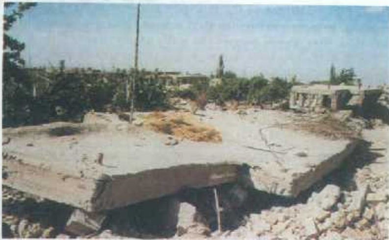
از تگول - ساخته شده با قالب بتن آرمه در روستا که به علت زلزله فرو ریخته اند
