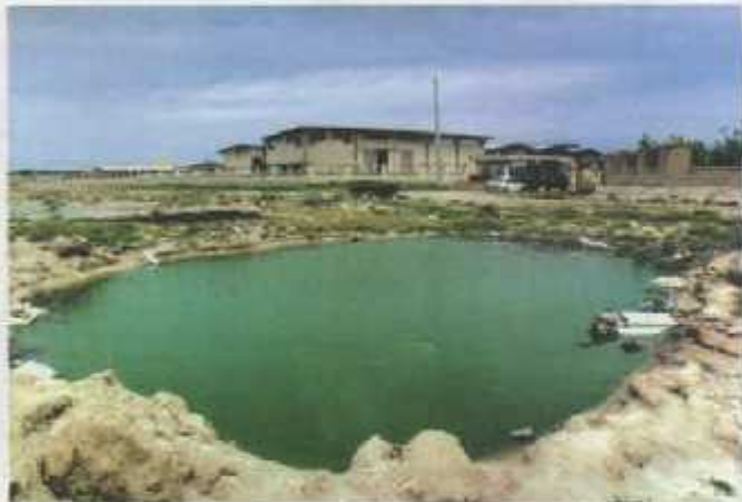
قزوین، پستگاه کارخانجات صنعتی
