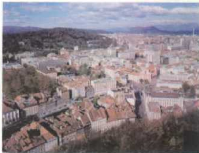
لیوبلیانا - نمای هوایی خیابان سبوسورسکال
