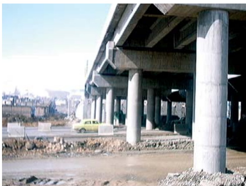
سنندج - بخشی از پل بهاران (دسترسی شهرک بهاران)
