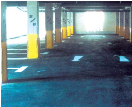
نمای داخلی یکی از طبقات پارکینگ مسجد ملا اسماعیل در یزد
