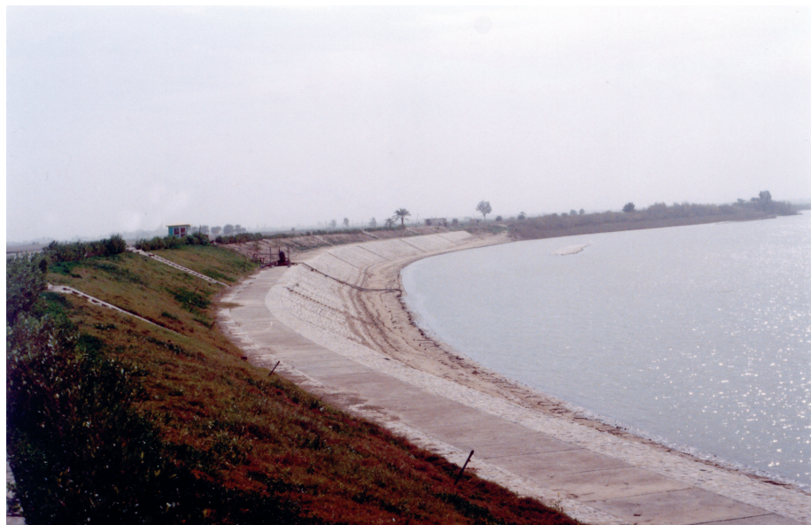
ساحل‌سازی قسمت جنوبی رودخانه کارون
