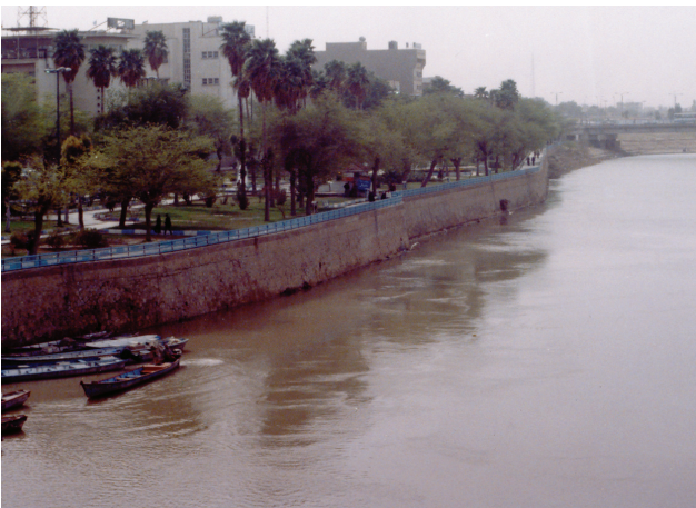
قسمت محدودی از ساحل‌سازی رودخانه کارون
