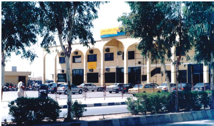
ساختمان تازه ساز بازار مرکزی شهر
