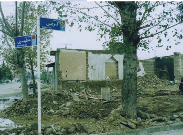
جوکی محله در حال تخریب
