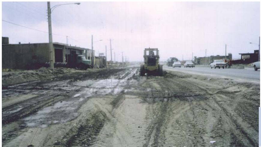
زیرسازی کوچه خاندملو
