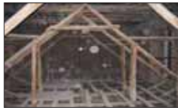
شکل ۱۲- استفاده از سیستم خیرا در بنا (مآخذ: نگارندگان)
