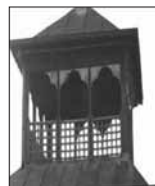
شکل ۱۴- استفاده از مصالح چوبی در شمس المماره (مآخذ: نگارندگان)
