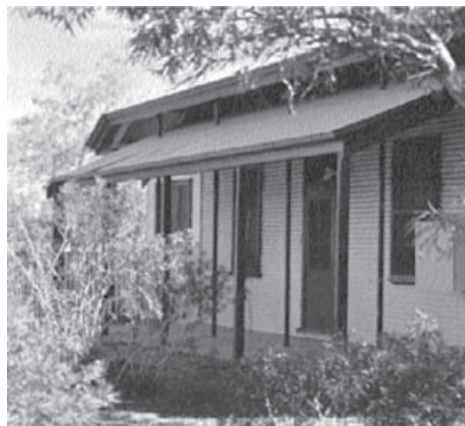
شکل ۳- نمای سقف دولایه یک دبیرستان در شهر ماری در شمال استرالیا جنوبی
