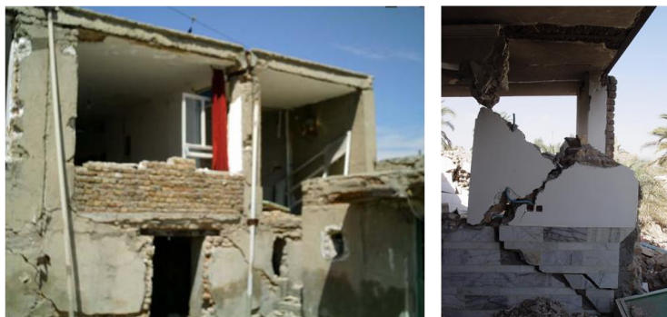
شکل پ-۲-۱۹- فروریختن دیوارها و در پی آن سقف
