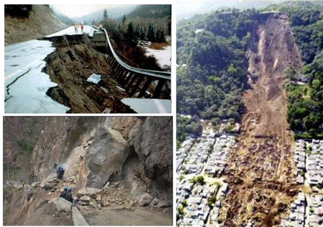
پ-۲-۶- مدفون شدن ساختمانها و تخریب راه اصلی بر اثر زمین لغزش
