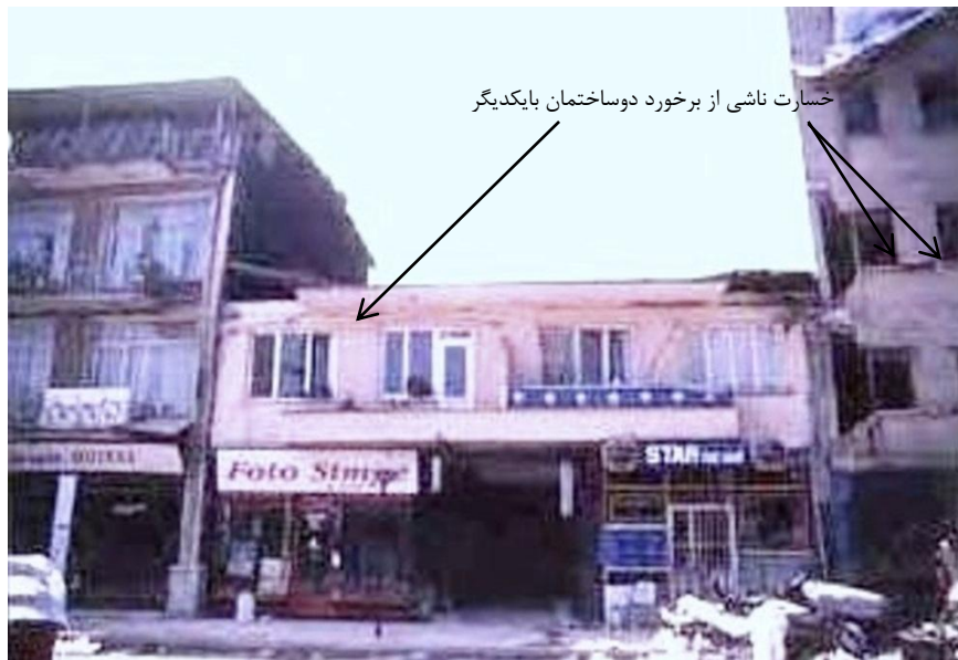
شکل پ-۲-۲۹- برخورد ساختمانهای مجاور و آسیب پیر بودن آنها
